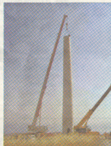
Fig. 3 - Montaggio di Torre per Turbina eolica Sito "Monte Mele" - Comune di Realmondo
