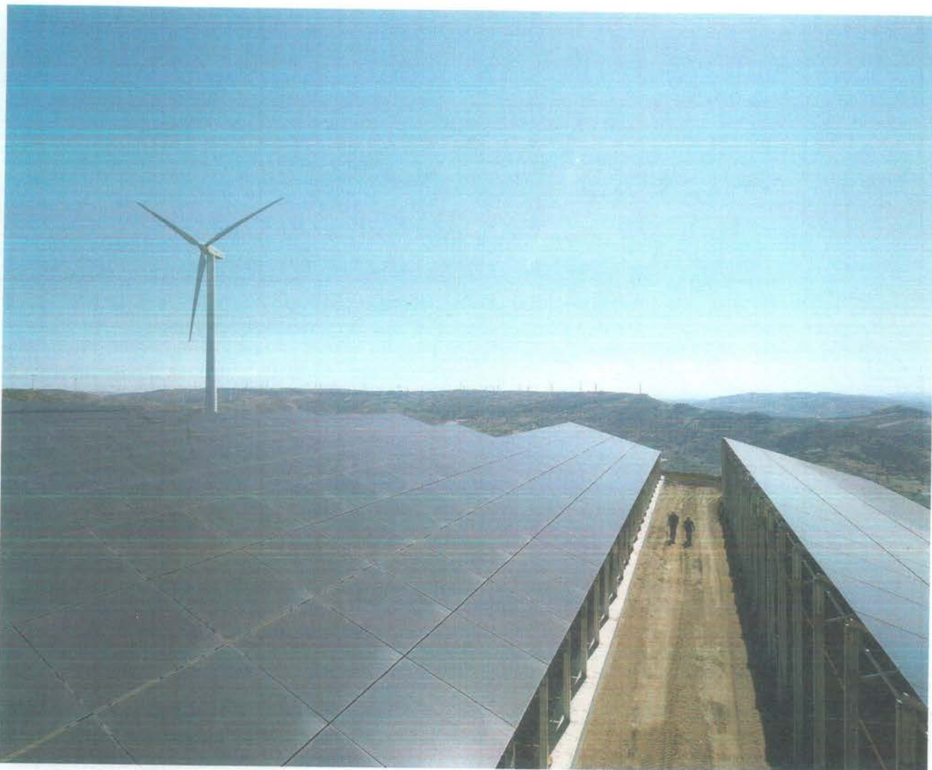
↳ L'impianto integrato - fotovoltaico, eolico e biomasse - di Serre Narbone, dove sono installati 7 MWp di fotovoltaico, 22 MWe di eolico e 30 generatori a biomasse che lavorano a supporto degli aerogeneratori.
