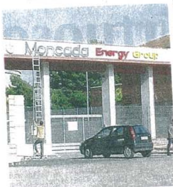
L'INGRESSO DELL'AREA MONCADA ENERGY GROUP
