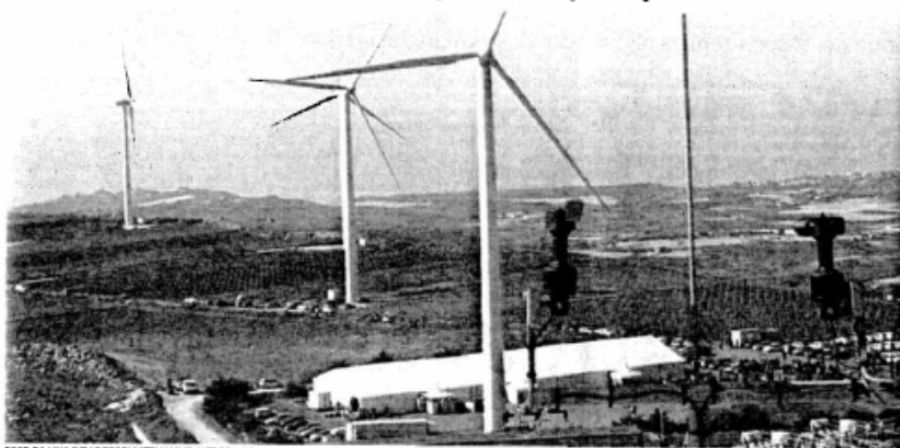
ECCO DA UNA DELLE TORRI METALLICHE ALTE 55 METRI COME SI PRESENTA UNO SCORCIO DEL PARCO EOLICO DI CONTRADA NARBONE IN TERRITORIO DI AGRIGENTO
